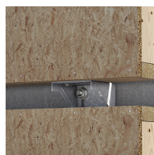
Asennus kahden puuelementin väliin
